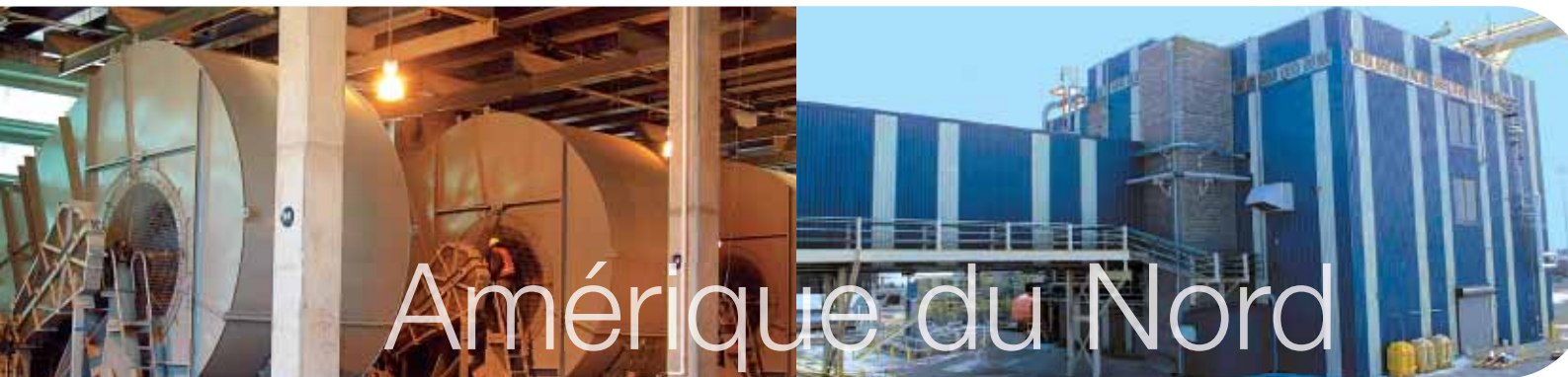
Tunnel de Boston : systèmes de ventilation (Etats-Unis)
