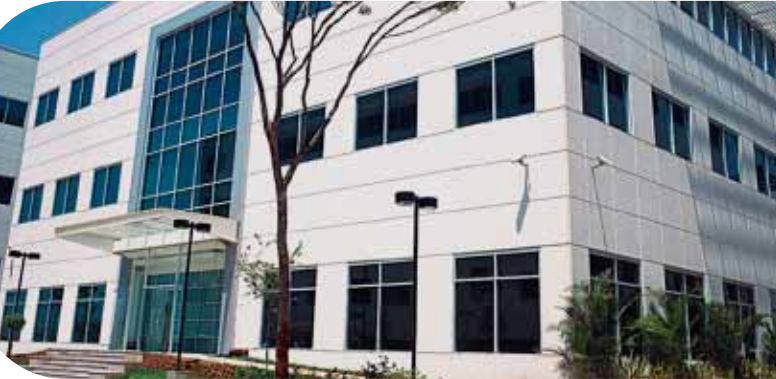
Data Center de MetroRed (Brésil)
