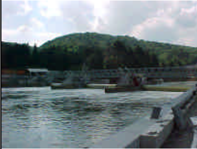
Nouveau barrage d'Anseremme
