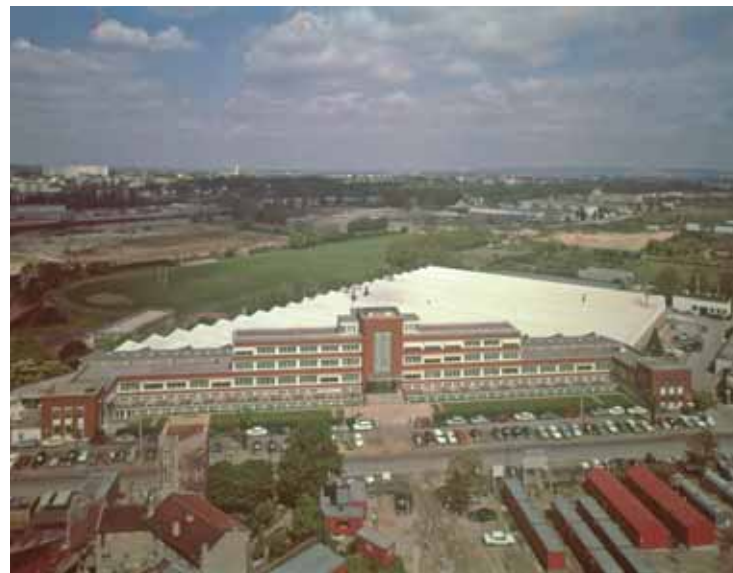
1949 : acquisition de l'usine de Rueil-Gare pour la fabrication d'appareillages de moyens et gros calibres
