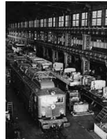
1970 - Atelier CM4 de montage de locomotive
